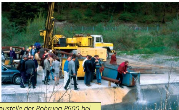
Baustelle der Bohrung P600 bei Lavey-les-Bains (Foto F.-D. Vuataz)
