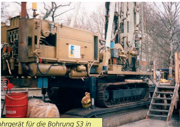
Bohrgerät für die Bohrung S3 in Bad Schinznach (Foto F.-D. Vuataz)
