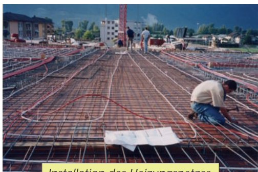
Installation des Heizungsnetzes in der Decke (Photo M. Anstett)
