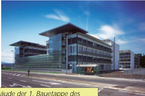
Die Gebäude der 1. Bauetappe des SUVA D4-Zentrums. (Photo P. Berchtold)
