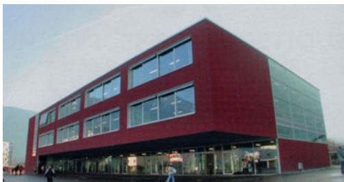
Die Primarschule in Fully (VS), gemäss dem Minergie-Standard gebaut (Photo E. de Lainsecq)
