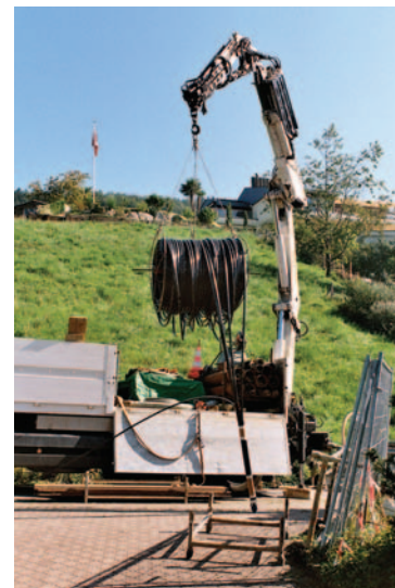
Erdwärmesonde auf Haspel bereit zum Einbau (Foto W. J. Eugster)
