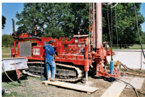
Raupenbohrgerät auf einer Bohrstelle (Foto W. J. Eugster)
