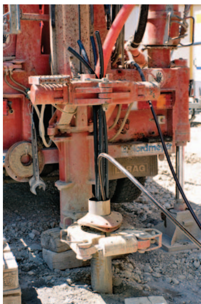
Fertig eingebaute Erdwärmesonde kurz vor der Injektion (Foto W. J. Eugster)
