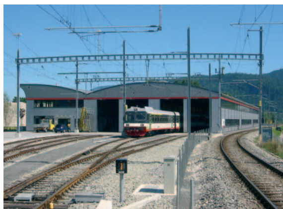
Das TRN Eisenbahndepot in Fleurier (NE) wird ebenfalls mit Grundwasser beheizt (Foto S. Cattin)
